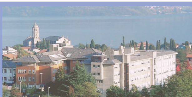
OSPEDALE GENERALE DI ZONA "MORIGGIA – PELASCINI" Via Pelascini, 3 22015 - GRAVEDONA ED UNITI (CO) Tel: (0344) 92 111 - Fax: (0344) 85 896 Ufficio Prenotazioni: (0344) 92 401
